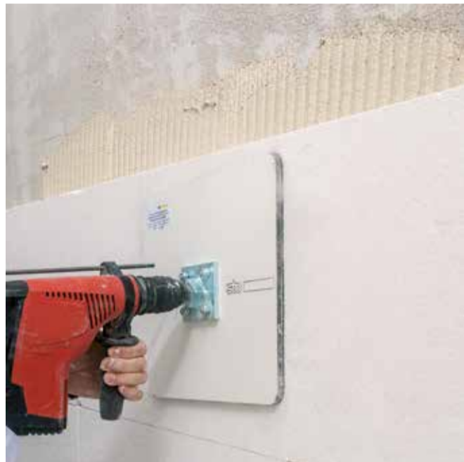
Bei der Sanierung eines Mehrfamilienhauses im Zürcher Seefeldquartier setzte der Bauherr auf eine Innendämmung mit Sto-Innendämmplatten und konnte so die historische Fassade erhalten.
